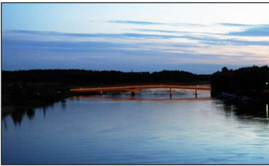
Penttilänranta Bridge, Finland
