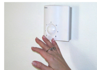
Med temperaturgivare kan de boende justera sin egen komfortvärme.
