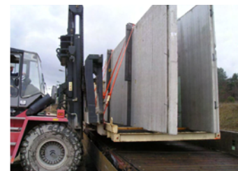
Miljövänliga transporter av byggmaterial är en viktig faktor. Här lastas prefabricerade material ombord på tåg.
