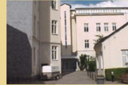
Trädgårdsgatan 12, Uppsala Eurobor®treatment 2003 Client: Akademiska Hus
