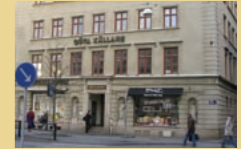
Göta Källare, Göteborg Foundation inspection 2003 Client: HIGAB
