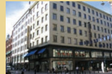
Alexanderinkatu 11, Helsingfors, Finland Eurobor®treatment 2003 Client: Kiinteistö Oy c/o Realco
